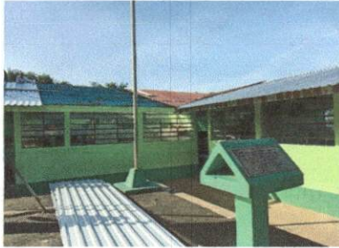
Foto1: Sustrucción de lámina
